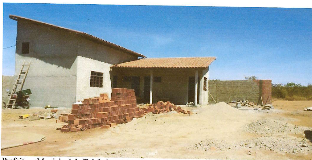
Figura 06- : Construção em andamento da sede da ASCAMART
