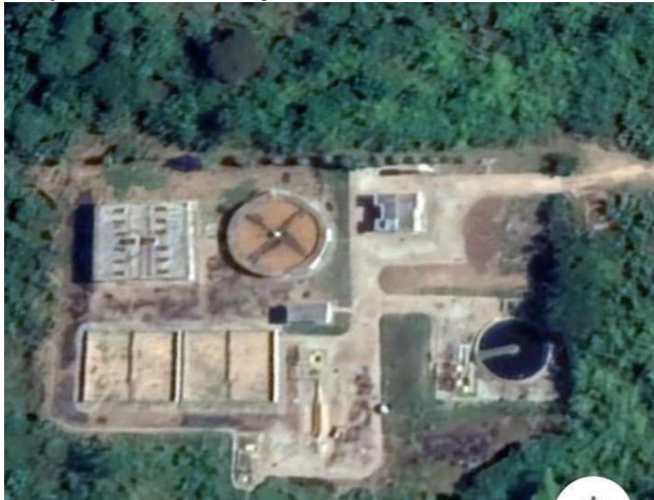
Figura 8: Estação de Tratamento de Água de Itambacuri - MG
