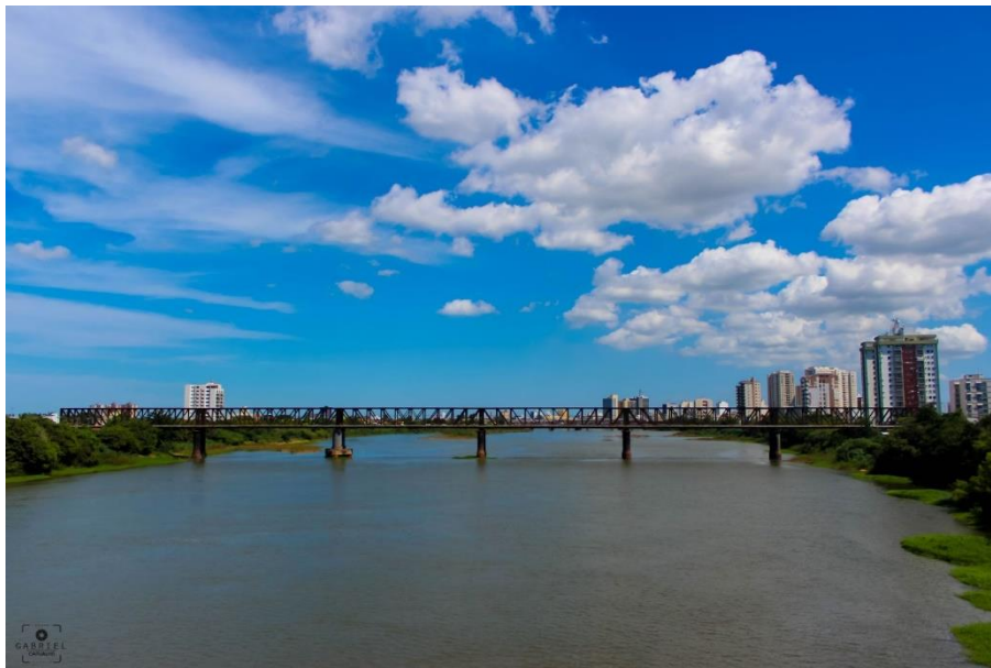
Figura 3 - Ponte da Leopoldina Railway
