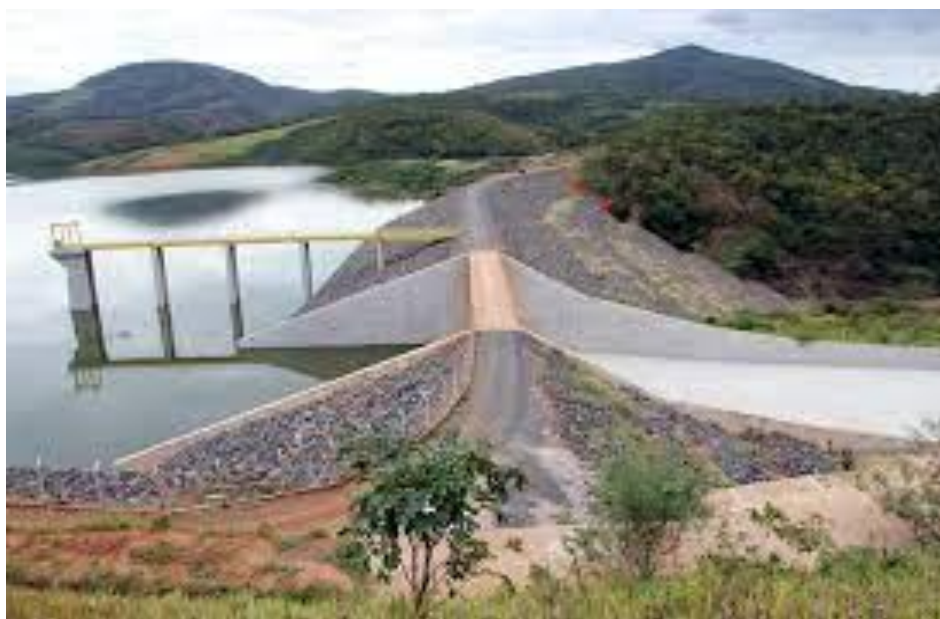
Figura 11 - Visão Superior - Barragem do Rio Setúbal
