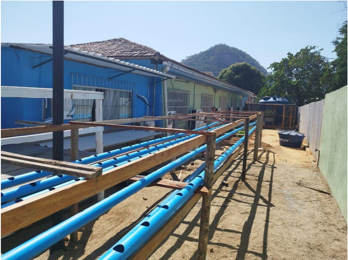
Figura 4 - Área utilizada para construção do Sistema Hidropônico, localizada próximo a horta da escola.
