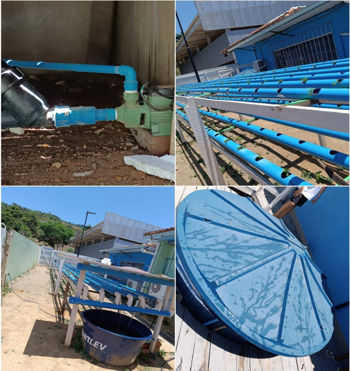
Figura 7 - Construção do sistema hidropônico utilizando PVC.
